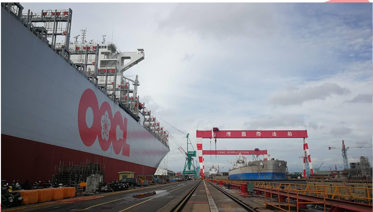
東方海外貨櫃航運公司(OOCL)脫硫洗滌器(scrubber)加改裝作業圓滿成功
